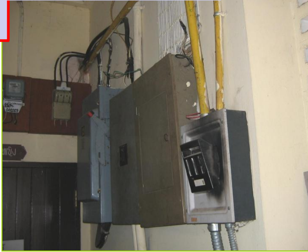
สภาพความเสียหายของสะพานไฟฟ้า
